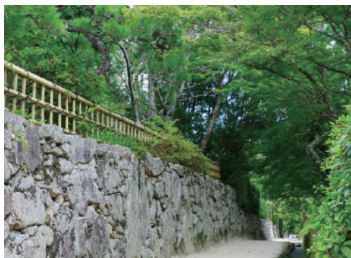
歴史的な建造物や街並みが残る 坂本のまちなみ(穴太衆積み石垣)
