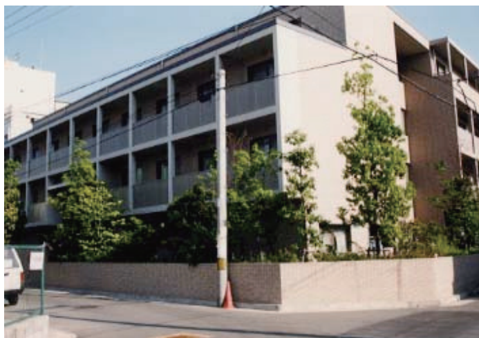
写真2 屋内消火栓が設置されていた企業の独身寮
