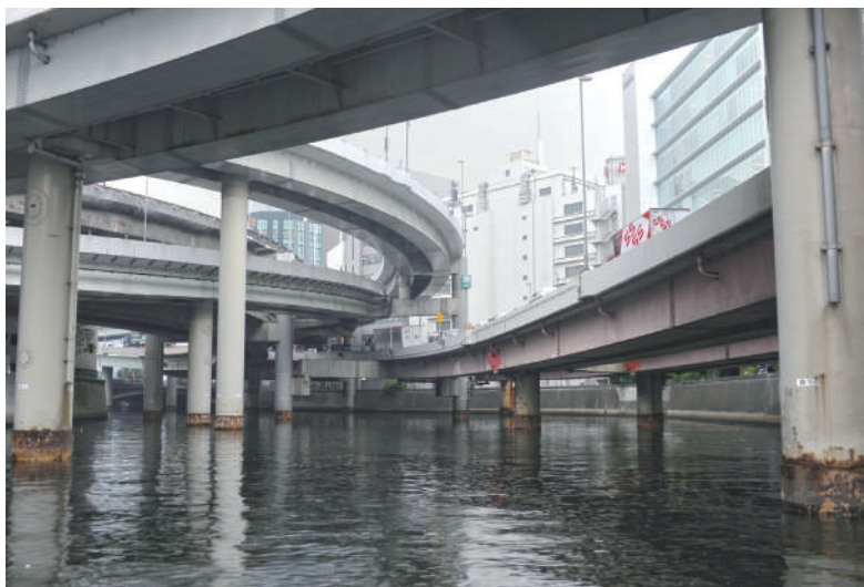
東京湾から日本橋川へ。首都高速江戸橋ジャンクション付近。 1963年に開通した高速道路では最も古いジャンクション(分岐部)
