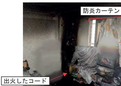
写真7 焼損した室内の状況
