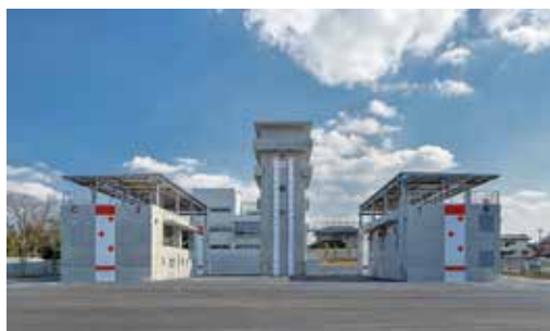
実煙による屋内検索訓練も可能な消防訓練センター
