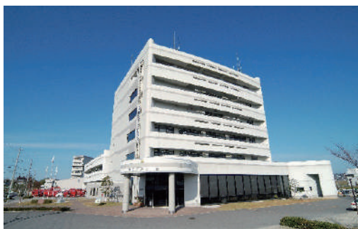
消防本部庁舎
