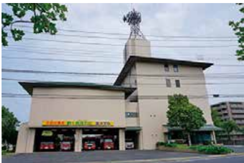
消防本部庁舎
