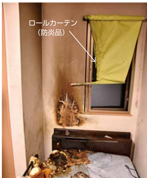
洋室内のロールカーテンの状況
