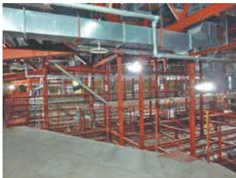
脱落防止処置をした天井裏
