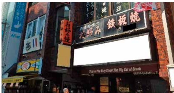
内照式看板の例
