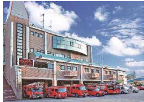
消防本部全景
