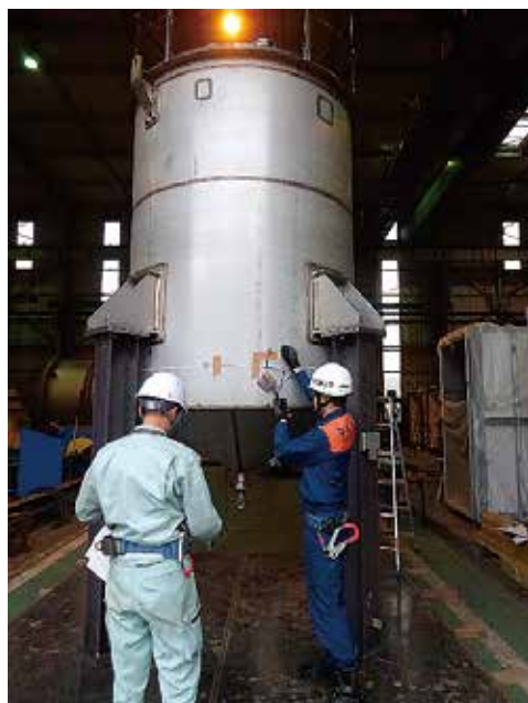
タンク完成検査前検査
