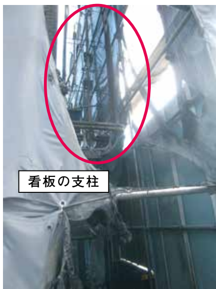
写真3 看板の形状に沿って工事用防災シートが燃焼・溶融した部分
