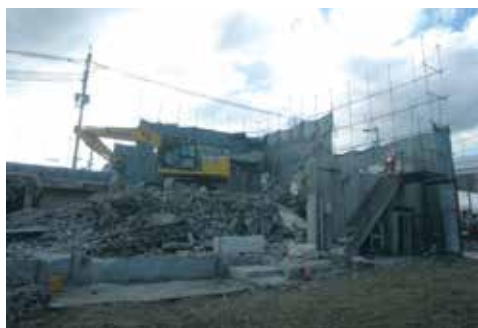
写真2 建物の解体が進んでおり、外壁の解体がほぼ終わっている状態
