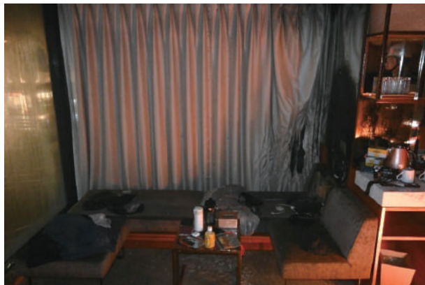
客室内のカーテンの状況
