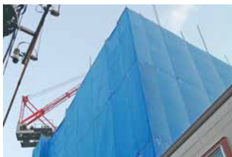
建築中の建築物に使用される工事用シート
