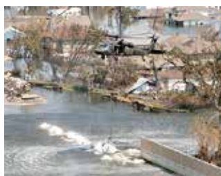
堤防決壊か所
